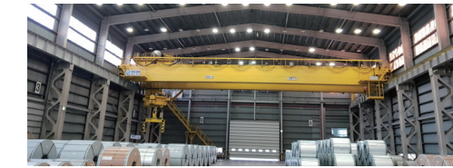
▶ LED 시공 전
